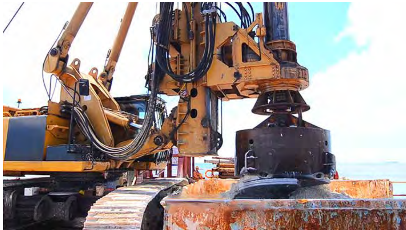
上图中正在使用旋转钻机移除桩钻孔中的珊瑚砂石。桩顶用网覆盖并用警戒线包围隔离。大桥施工过程中无人员伤亡，这体现了良好的现场安全管控能力。
