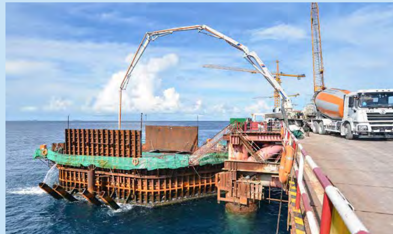
2017年5月13日，主桥首个承台混凝土浇筑。 2017年7月20日，中马友谊大桥主桥承台全部施工完成。
