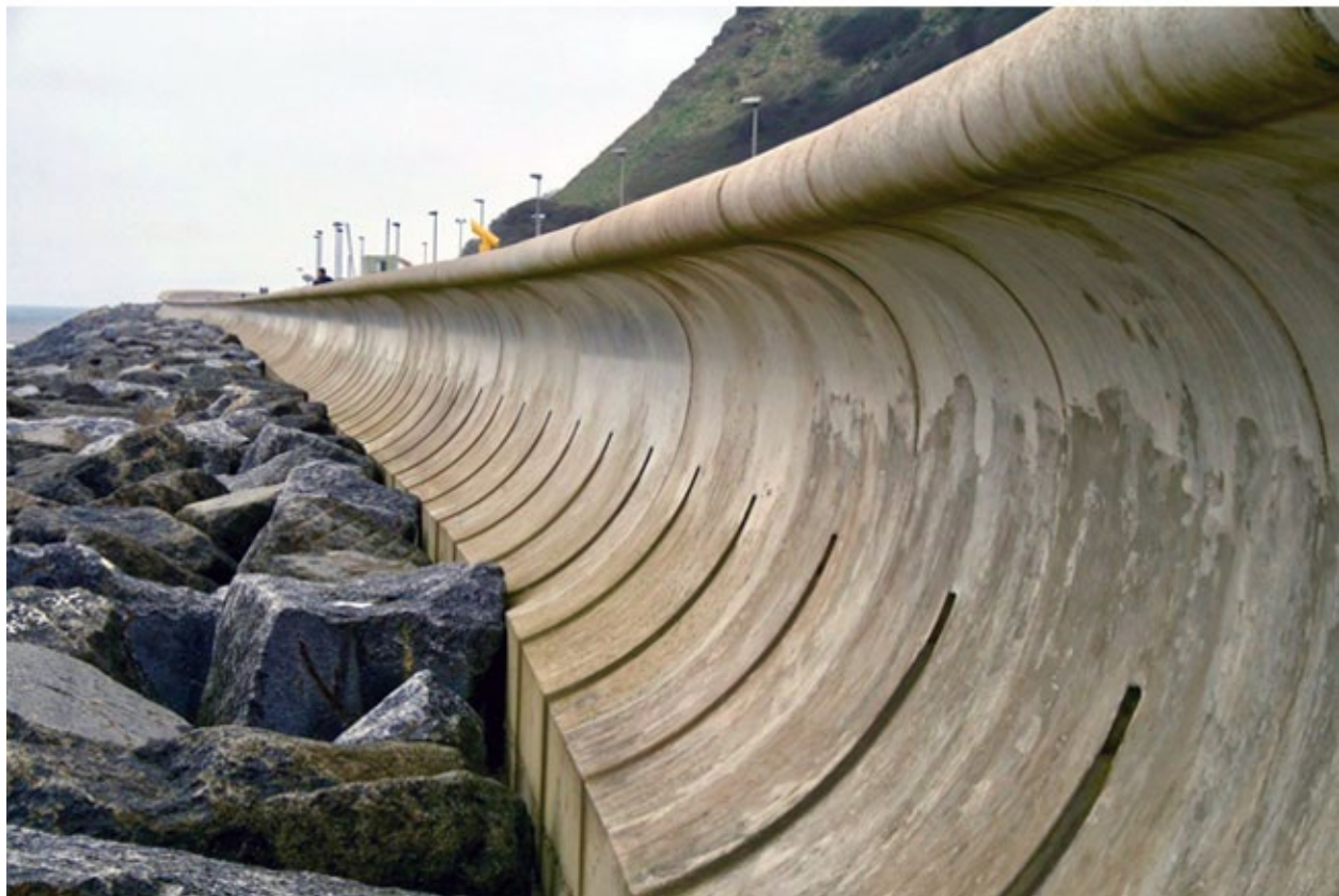
این سازه ها در مقابل موج های شدید و در زمان طغیان های شدید دریا، به منظور محافظت از ساحل و جلوگیری از فرسایش و تخریب سازه های ساحلی دیگر، به کار می آید.
