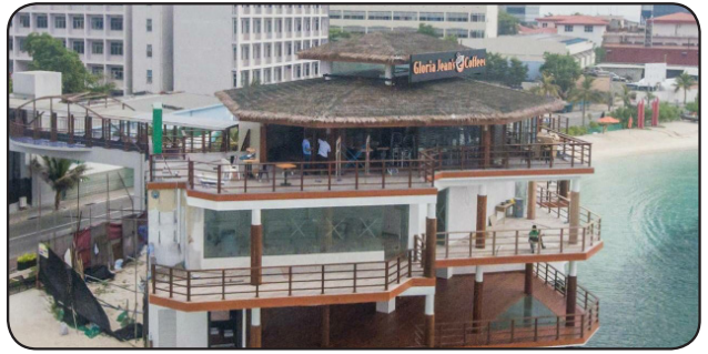
▲ මහලයේ වැඩ සිදු කිරීමේදී ජනප්‍රියතම ගොඩනැගිලි වන මහලයේ 25 වන මහලයේ වැඩ සිදු කිරීම.
