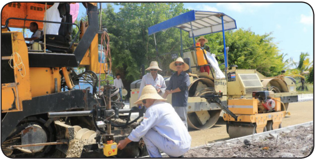
▲ මහලක්ෂි ප්‍රදේශයේ පවතින ප්‍රධාන මාර්ග වැඩපිටිමේ වැදගත්කම පිළිබඳව පිළිගැනීමේ ආරම්භක ක්‍රියාමාර්ගයක්. මෙහිදී පුළුස්සුම් යන්ත්‍රයක් භාවිතයට ගෙන එනු ලැබ ඇත.
