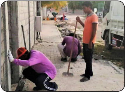
▲ මහලක්ෂි ප්‍රදේශයේ පවතින ප්‍රධාන මාර්ග වැඩපිටිමේ වැදගත්කම පිළිබඳව පිළිගැනීමේ ආරම්භක ක්‍රියාමාර්ගයක්. මෙහිදී පුළුස්සුම් යන්ත්‍රයක් භාවිතයට ගෙන එනු ලැබ ඇත.
